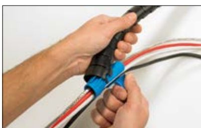
Posizionare l'utensile applicatore HAT ad un capo della guaina Helawrap.
