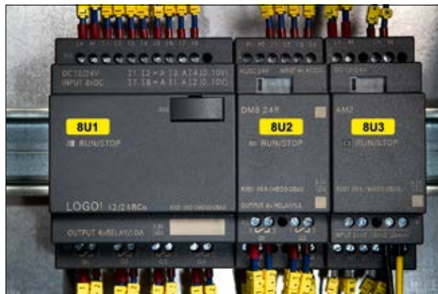
Identificazione di un quadro elettrico.
