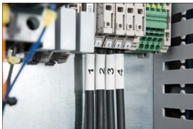
Marcacavi termorestringenti TLFD DS per identificare chiaramente i pannelli di comando.
