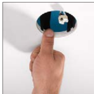
2. Spingere i dentini all'interno del cartongesso per evitarne lo spostamento.
