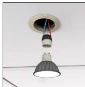
3. Collegare il faretto all'attacco e fissarlo in posizione.
