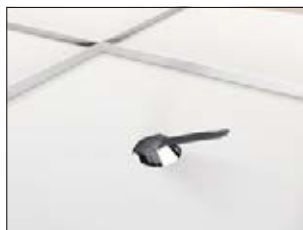
1. Inserire il supporto di montaggio attraverso il foro.
