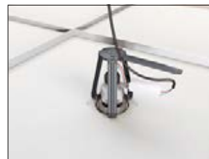
4. Collegare l'alimentatore e assicurare i cavi con il fermacavo.
