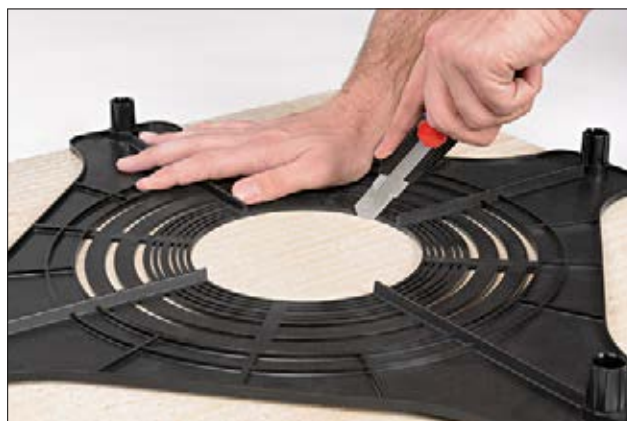
Utilizza lo SpotClip-Plate come maschera per tagliare il pannello del controsoffitto.
