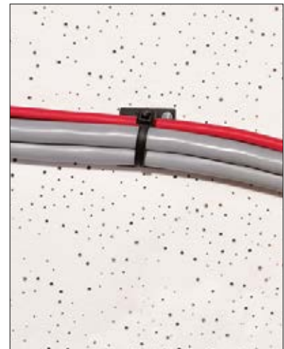
3. Se l'installazione è finita, la Q-tie può essere tensionata e tagliata manualmente o con un utensile.
