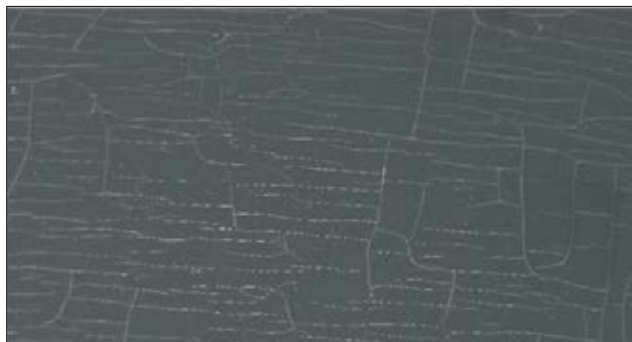
La struttura è stata danneggiata completamente dalle radiazioni UV.
