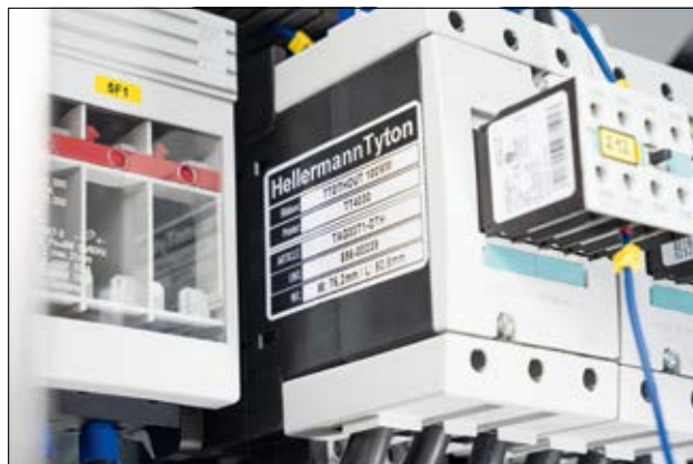
TAG33T1-DTH applicata su pannello di controllo.
