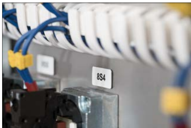
Panel label 1220 - Adesivo ad elevate performance per garantire una adesione anche su superfici non uniformi.
