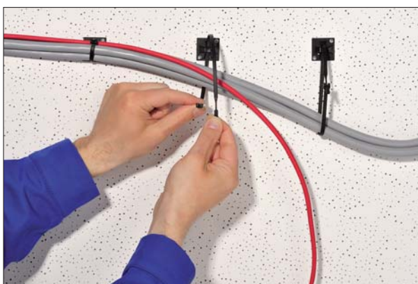
Le fascette Q-ties possono essere utilizzate per applicazioni di fissaggio temporanee o definitive.
