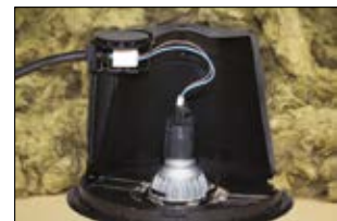
Vista all'interno dello SpotClip-Box.
