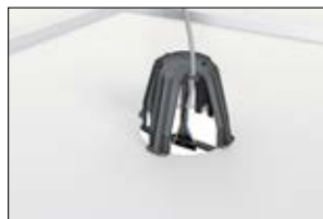
2. Spingere le apposite alette nel cartongesso per prevenire lo spostamento e rimuovere l'attrezzo.
