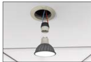
3. Collegare il faretto all'attacco e fissarlo in posizione.
