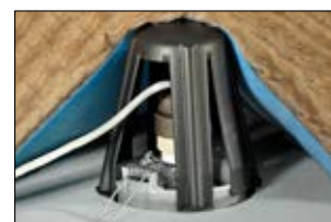
SpotClip-II applicato sotto l'isolante in lana di vetro.
