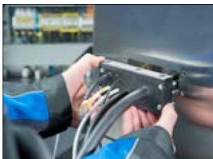
Non è necessario installare una guarnizione aggiuntiva
