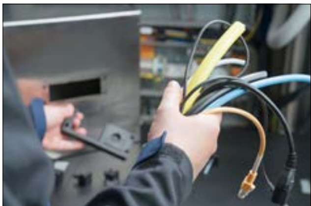
Come instradare e fissare un'alta densità di cavi intestati in un colpo solo?
