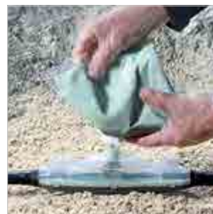
L'ugello in combinazione con gli adattatori permette di colare la resina in maniera semplice ed efficiente senza sbavature.
