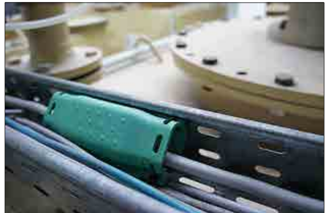
Giunto in gel Relifix V utilizzato per riparare un cavo.
