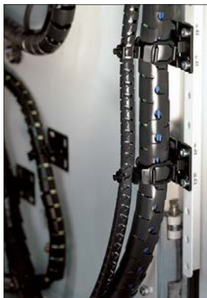
HWPP viene utilizzata prevalentemente dove sia richiesta elevata flessibilità, tipo all'interno delle porte dei quadri elettrici.
