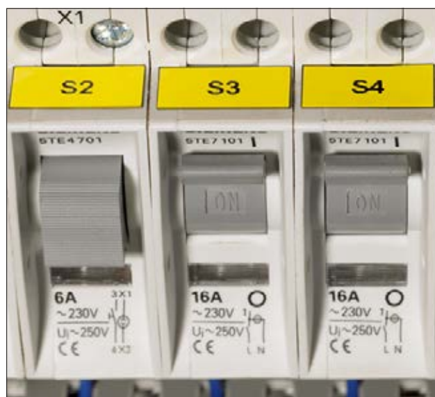
Etichette facili da identificare garantiscono una facile gestione dei cablaggi.
