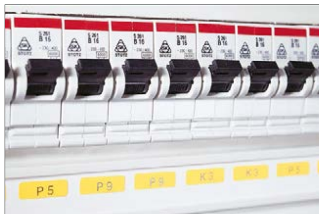
Identificazione di un quadro elettrico.
