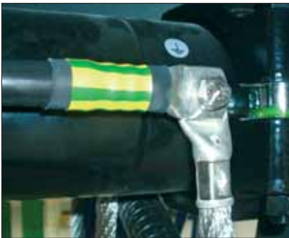
Il TF21 giallo-verde garantisce protezione nel tempo per capicorda ed evidenza chiaramente i cavi di messa a terra.
